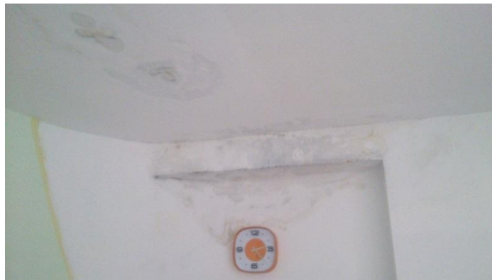
U tijeku sanacije
